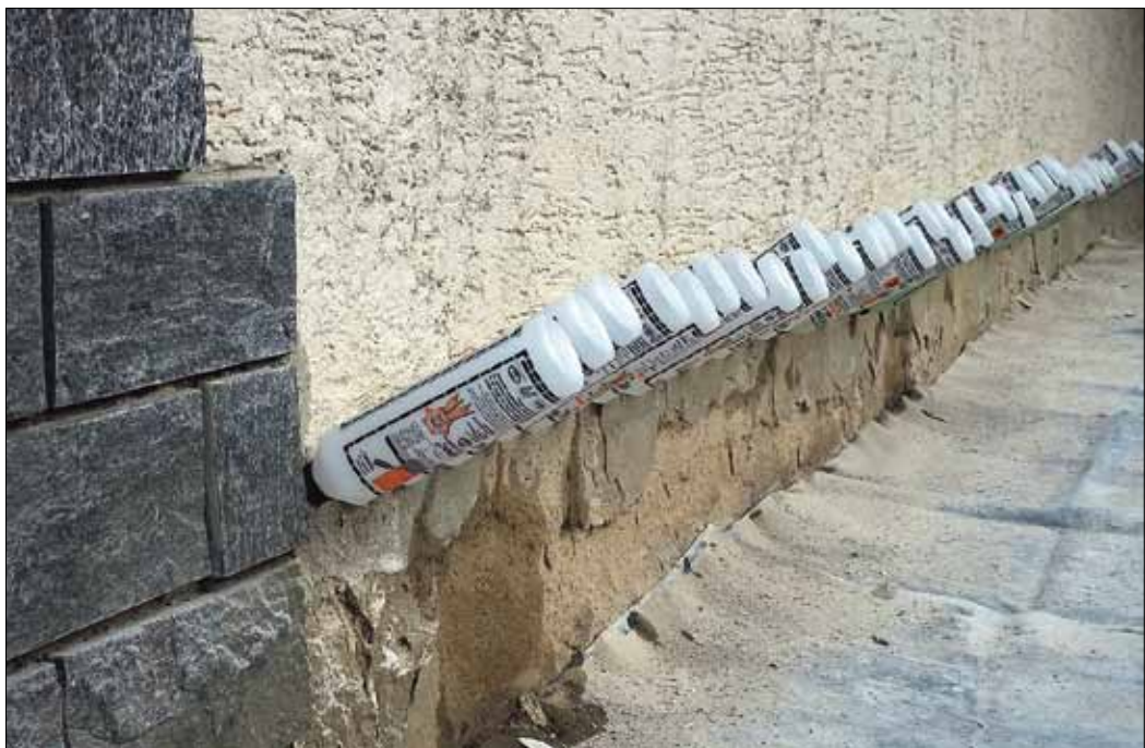
Der VEINAL-Fachbetrieb Rhein-Main bietet eine bewährte Methode, bei der wasserfreies Silikonharz über Bohrkanäle drucklos oder im Niederdruckverfahren in das Mauerwerk injiziert wird. Foto: Archiv
